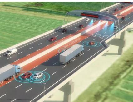
而高速公路超限超载非现场执法，利用称重设施、监控系统、高清车牌识别系统等设备设施，收集涉嫌超限超载的车辆车型、车牌、称重信息、车辆照片、视频资料等原始数据，向属地交通运输执法部门和公安交通管理部门抄告。执
