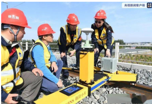
图 4-2 北斗惯导小车在铁路建设中的应用 1
