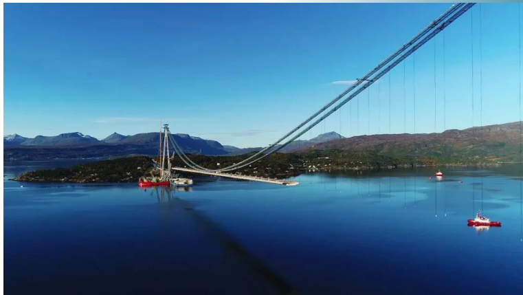
挪威贝特斯塔桑德大桥(四川路桥建设)
