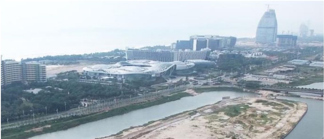
图 2 桥位实景照片
